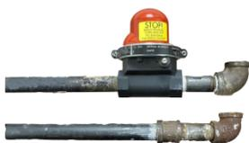
7. 使用 PSP 钢塑复合阀配置新的管道。从墙面始为阀轴留出 5" 到 6" 空间，方便气门复位。
